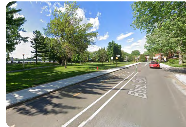
Réaménagement du boulevard Gouin, Montréal
