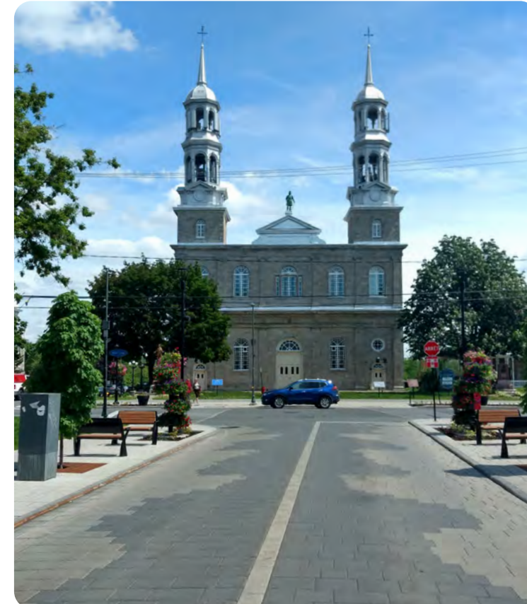
Réaménagement de l'interface de l'église, Saint-Eustache
